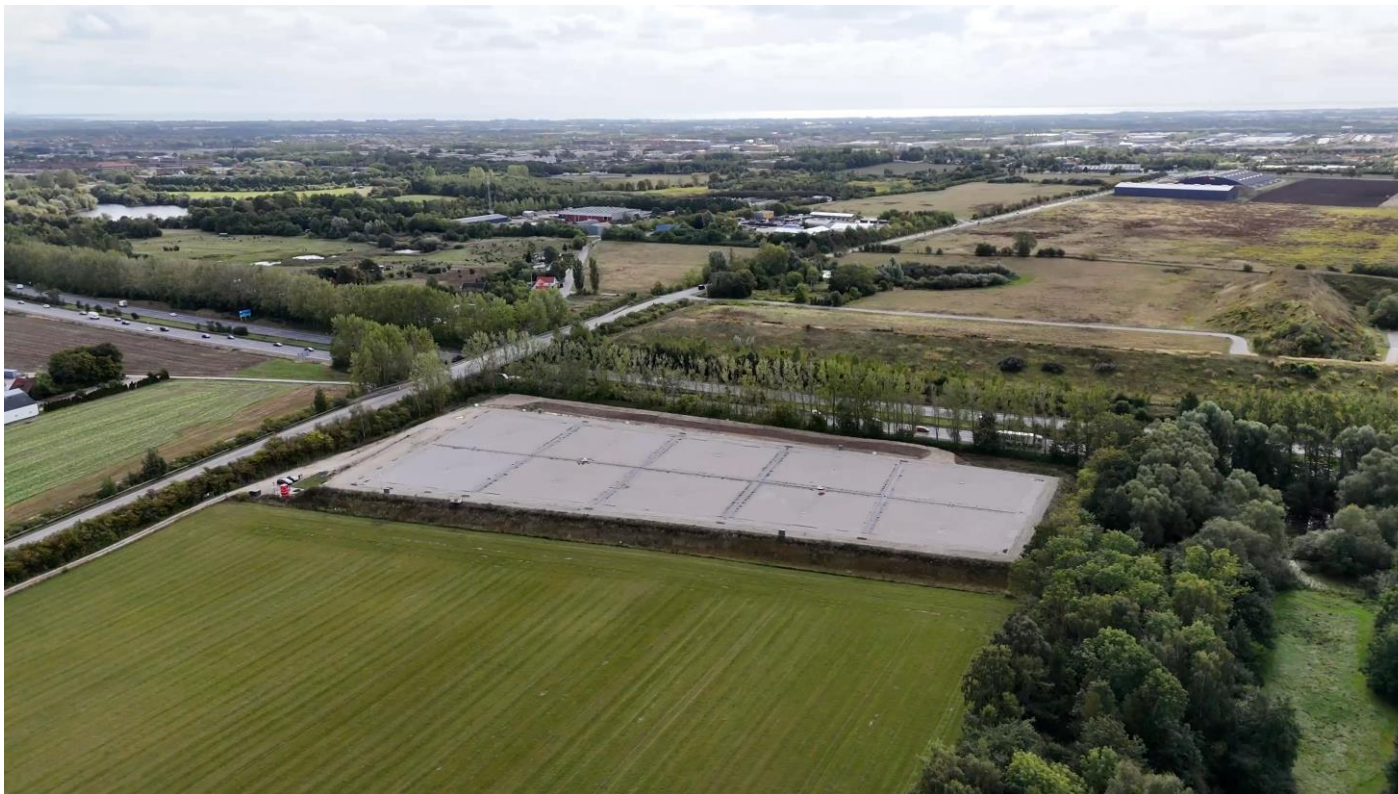
Erdbeckenspeicher: Høje Taastrup / Dänemark, Aalborg CSP
