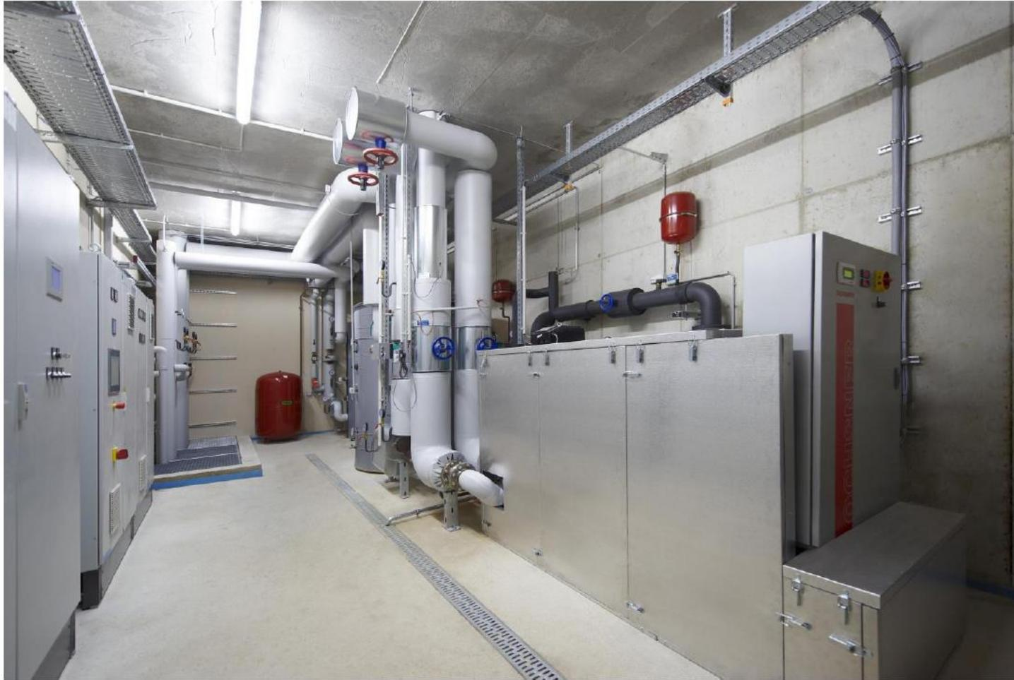
Abbildung 5: Blick in den Heizraum. Im Vordergrund WP OCHSNER ISWS150ER2 samt kompletter Schallschutzverkleidung (Quelle: OCHSNER Wärmepumpen, Tiefbauamt Stadt Straubing, Dipl.Ing. (univ.) Christina Pop)
