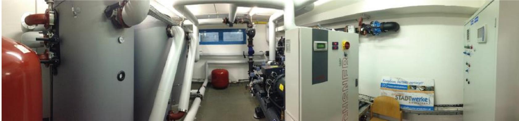
Abb.19: Die OCHSNER Wärmepumpe IWWS210ER2 (hier im Bild samt den in Serie geschalteten Pufferspeichern) kann dank der hohen Abwassertemperaturen von ca. 22°C äußerst effizient arbeiten. OCHSNER Wärmepumpen GmbH.
