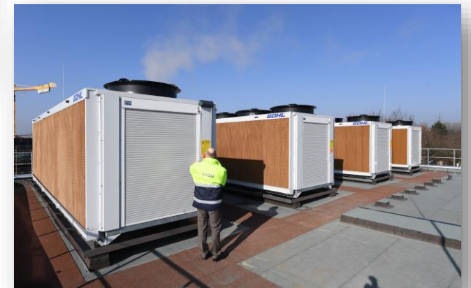
Hybrid Rückkühler 5 x ~600 kW th
