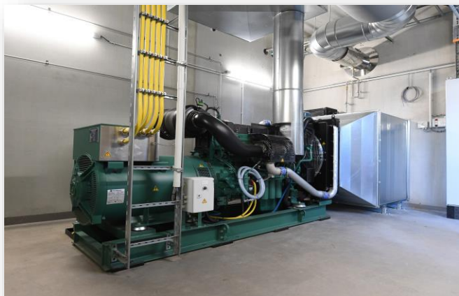
Notstromversorgung 400 kVA
